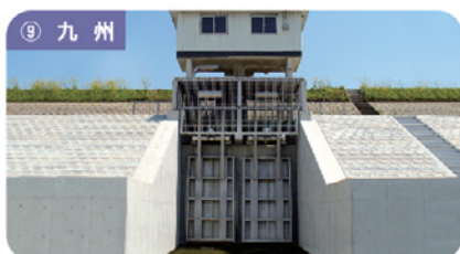
【荒瀬樋門】2.00m×3.50m 2連 発注者：九州地方整備局 筑後川河川事務所
