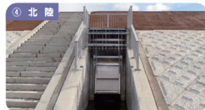
【元中子樋門】1.20m×1.30m 発注者：北陸地方整備局 信濃川河川事務所
