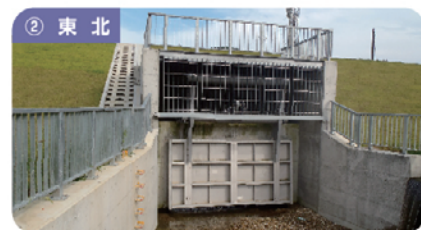
【小繋川排水樋門】4.70m×2.30m 発注者：東北地方整備局 能代河川国道事務所
