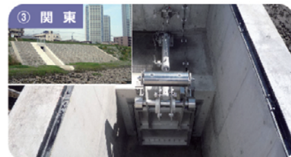
【二子玉樋管】1.00m×1.00m 発注者：関東地方整備局 京浜河川事務所
