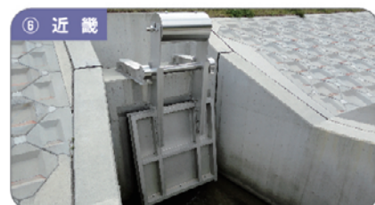
【野間川排水樋管】160m×1.60m 発注者：兵庫県 北播磨県民局
