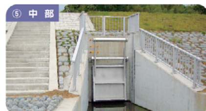
【牛尾樋管】1.50m×1.50m 発注者：中部地方整備局 静岡河川事務所
