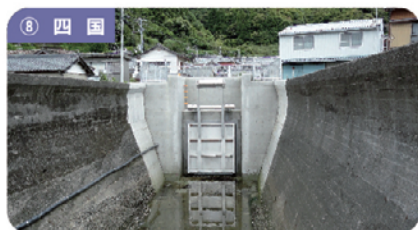
【No55水門】2.00m×2.00m 発注者：高知県 須崎市
